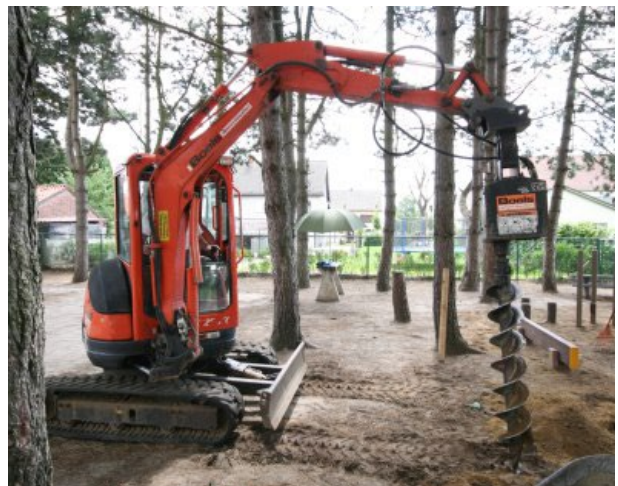
Bij een moeilijke bodem (wortels in bosgrond, keien in de grond etc.). Eventueel een graafmachine met een grondboor gebruiken.
